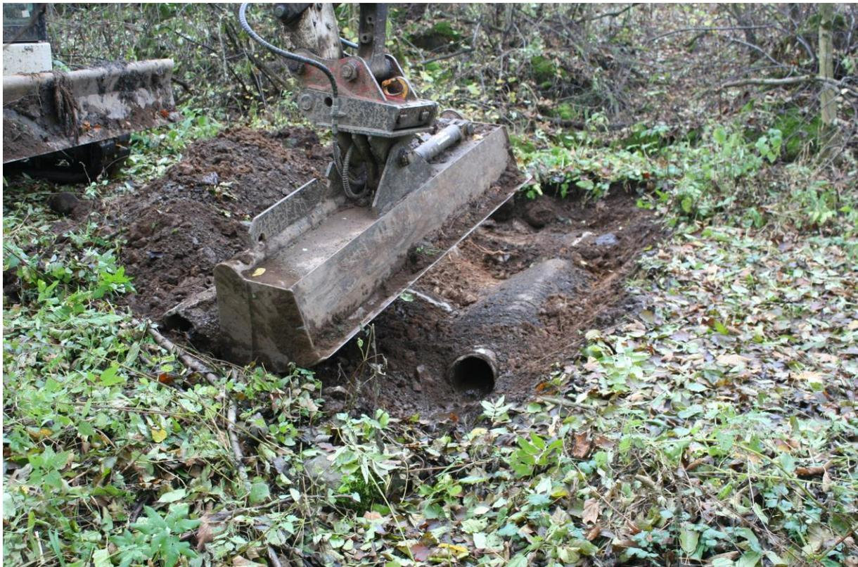
*Abb.: Entfernen der Verrohrung unterhalb der Herrnhecken-Quelle 2*
